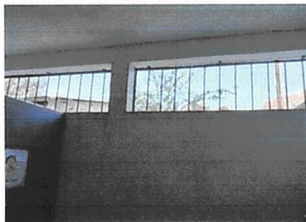
Foto 4: Módulo 5: Sustitución de vidrio en ventanas de baño.
