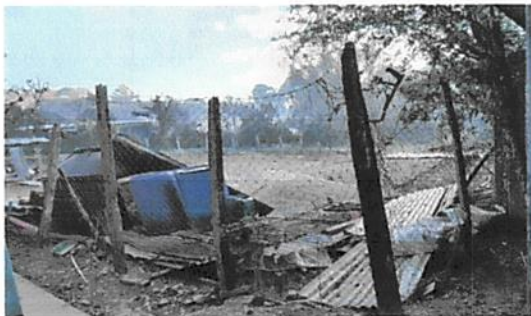
Foto 1: Módulo 1: Sustitución de muro perimetral existente por muro de mampostería y malla compuesto por cimientó corrido y tres hiladas de block.
