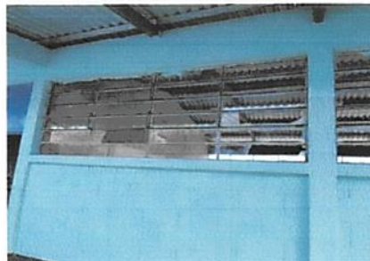
Foto 2: Módulo 2: Remozamiento de ventanas y sustitución de vidrios.
