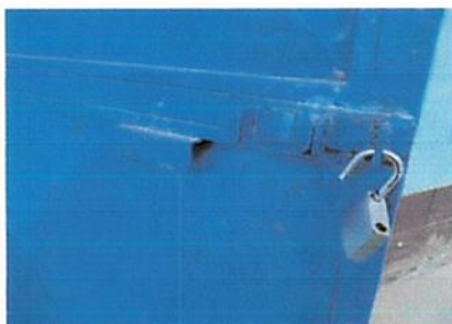
Foto 3: Módulo 4: Sustitución de chapas en puertas de aulas y cocina.
